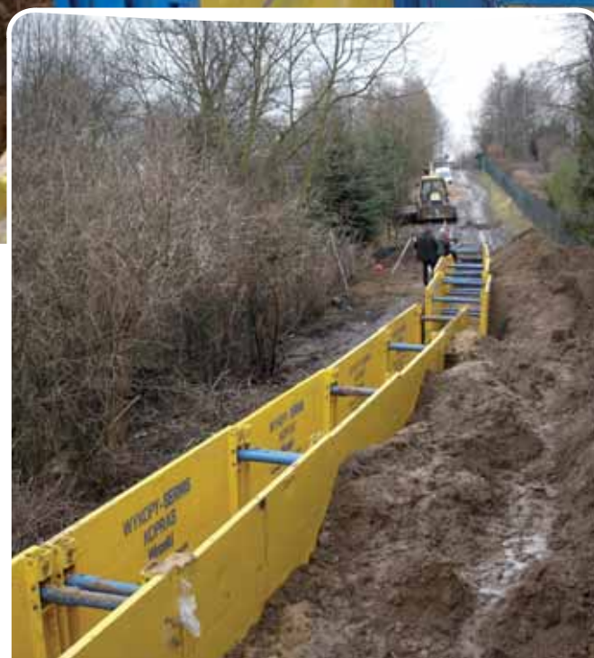
Fot. 2. Obudowa wykopu typu boks
